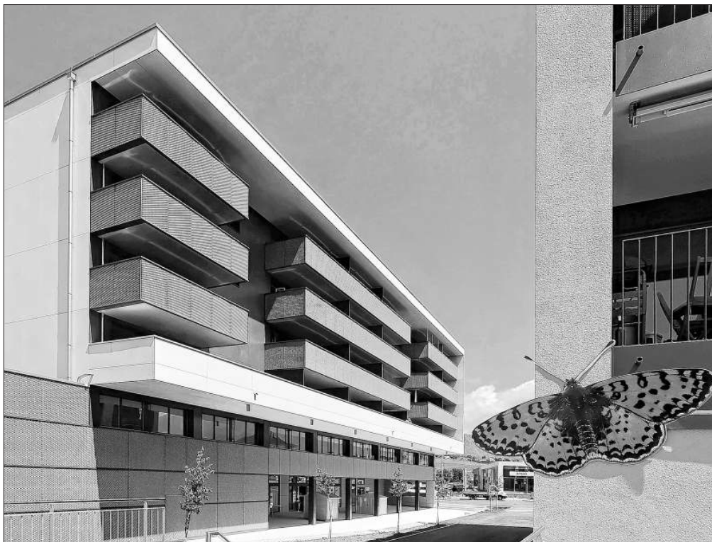
Quelque 2000 m 2 de bois suisse ont été utilisés pour le bâtiment de la Landi de Bulle. VINCENT MURTH
